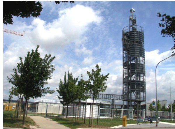
Solarturm in Heilbronn
