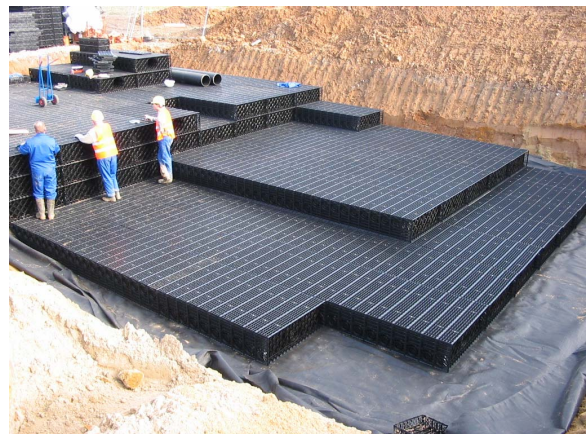
Abb. 2: Einbau eines Systems für ein Einkaufszentrum
