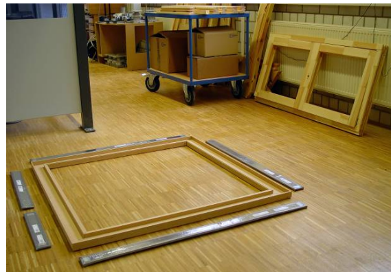
Abb. 1: Zusammenstecken der Holzschale, Einlegen der Vakuumdämmelemente
