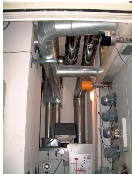
Abgas- und Schwadenführung
