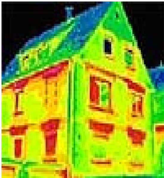
Abb. 1: Thermografieaufnahme eines Hauses
