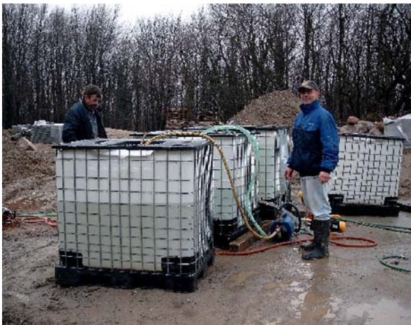
Luftfreie Befüllung der Anlage mit Sole – Lehrgangsaufnahme
