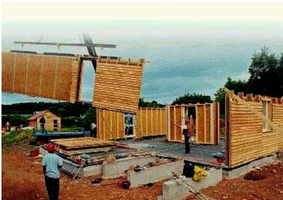
Aufbau eines Holzhauses
