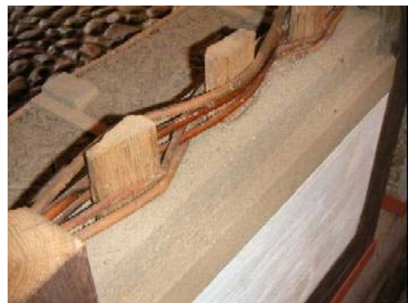
Abb. 1: Querschnittsansicht einer Wand mit Lehmputz
