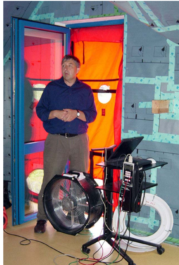
Einbau der Messapparatur und die Erläuterung der Arbeitsabläufe der Blower-Door-Messung
