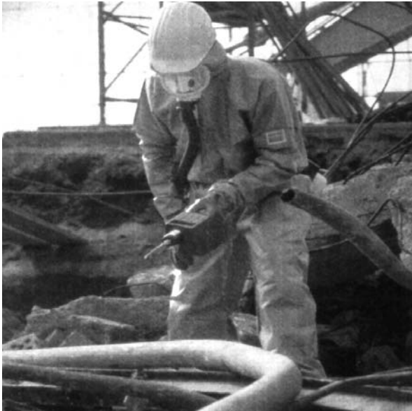
Arbeitssituation mit Asbest
