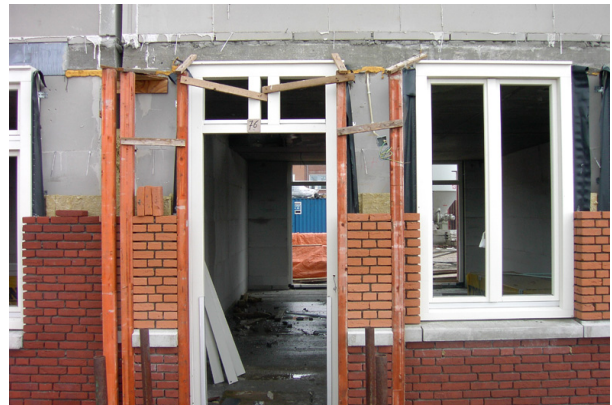
Fenster werden eingemauert
