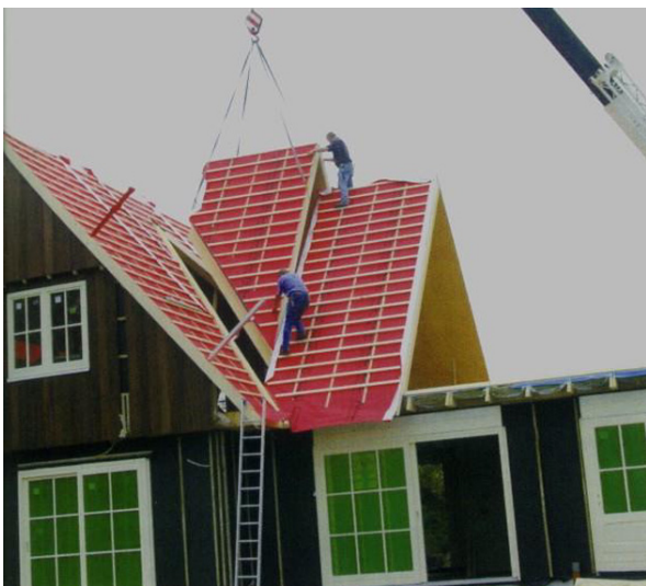
Aufbau eines Dachelementes
