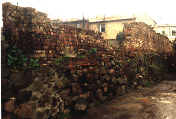
Stadtmauer vor der Sanierung
